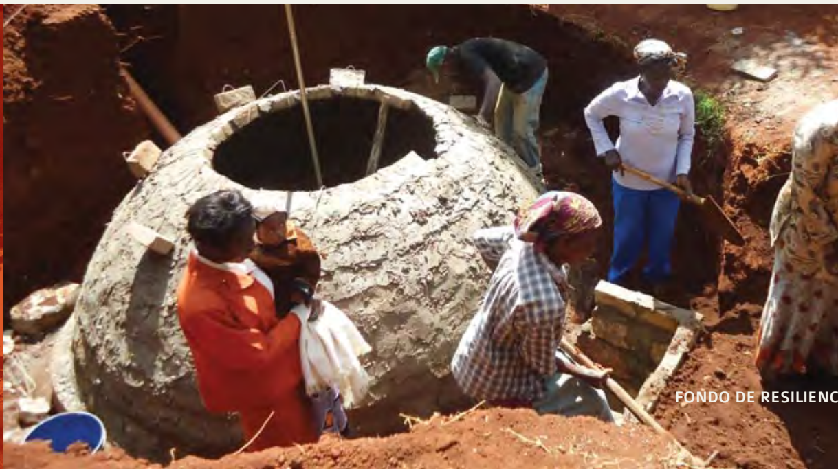
Construcción de tanques productores de biogás en el Condado de Kiambu, Kenya
